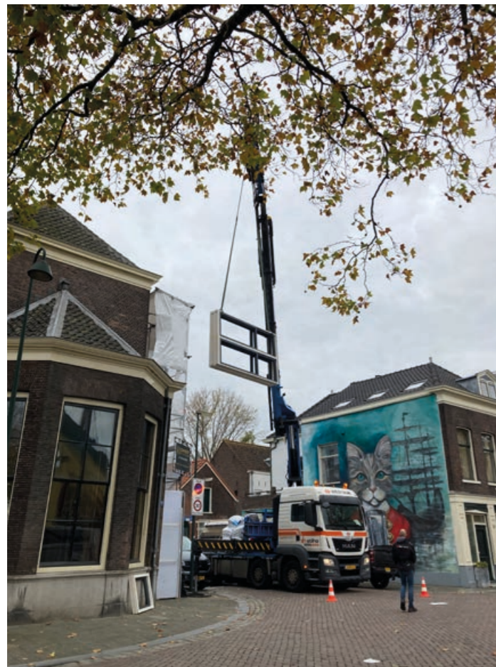
Plaatsing van de kozijnen
